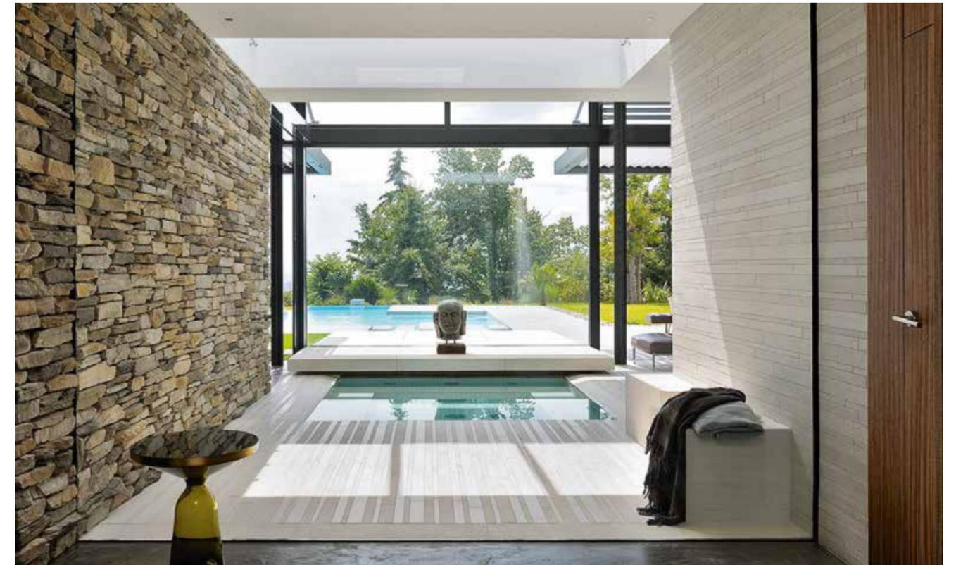
et techniquement garantis. Composée de grands cadres coulissants, la façade vitrée peut s'ouvrir sur la majeure partie de sa longueur, estompant la limite entre l'intérieur et l'extérieur en été. La façade est suspendue d'une structure métallique en porte-à-faux constituée de montants croisés, tendus et élancés, disposés en quinconce à l'intérieur de la maison. Cette ouverture est accompagnée d'une pergola bioclimatique à lames orientables, dont la structure a été modifiée.
